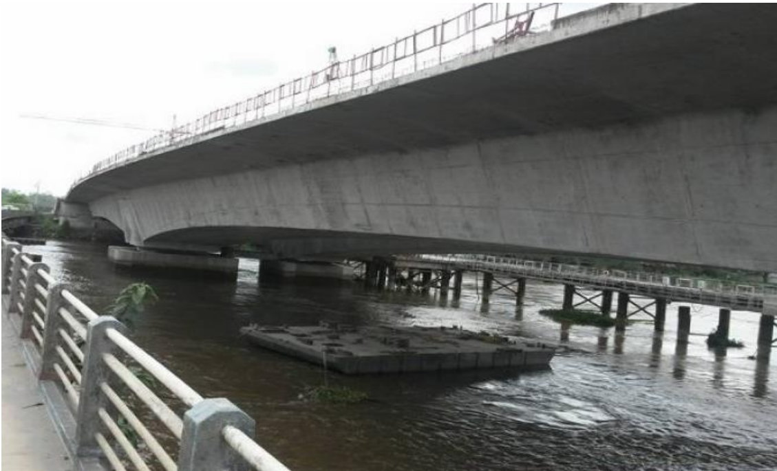
Photo 1: Deuxième pont sur le Wouri(en construction)
